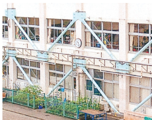
耐震工事 [ ② ]
