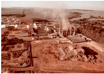
資料2 〈バイオエタノールの製造工場〉
