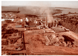
資料2 (バイオエタノールの製造工場)
