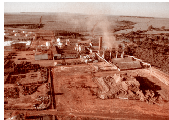
資料2 (バイオエタノールの製造工場)
