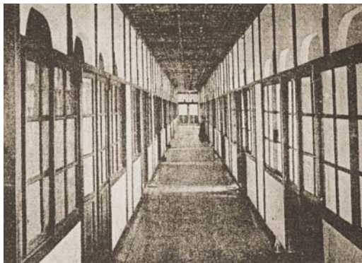
西病棟の廊下
